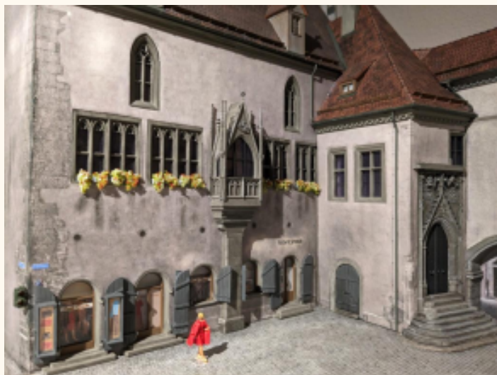
Mit Fotodruck und 3D-Drucke gestaltete Fassade des Alten Rathauses
